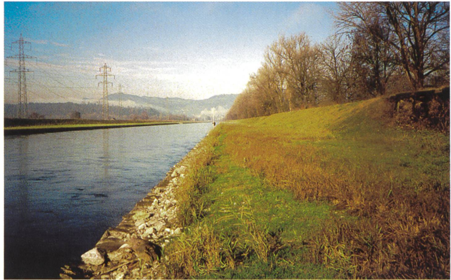
Bild 1. Rechtes Hochwasservorland des Linthkanals bei Profil 38.
