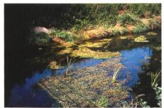
Bild 4. Verkrautung und Verschlammung Rechter Hintergraben in der Nähe des Durchlasses Au.
