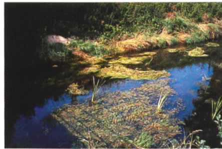
Bild 4. Verkräutung und Verschlämmung Rechter Hintergraben in der Nähe des Durchlasses Au.
