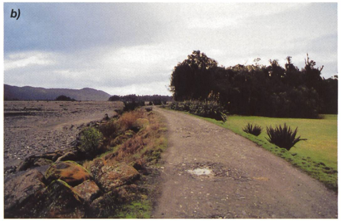
Bild 5. Gefährdete touristische Infrastruktur in Franz Josef, Beispiel Hotel: a) Hotelpark; b) Hochwasserschutzdamm mit auflandendem Waiho-Fluss links und Hotelpark rechts.
