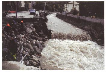
Bild 12. Durch das Hochwasser vom 14./15. Oktober 2000 zerstörte Ufermauer an der Saltina, im Kolkbereich eines Absturzbauwerks.
