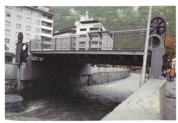
Bild 11. Hubbrücke über die Saltina in Brig-Glis in gehobenem Zustand (Aufnahme am 17. Oktober 2000, zwei Tage nach dem Hochwasser).
