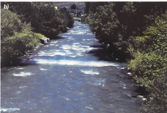
b) korrigierter Abschnitt mit Schwellen im Dorf;
