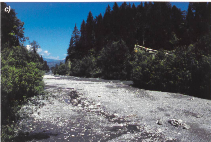
c) Dosierstrecke am Ende eines der Geschiebe- auffangräume des Kieswerks.
