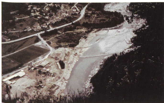
Bild 1. Kieswerk an der Maggia bei Avegno TI mit totalem Geschieberückhalt in Auffangbecken (Aufnahme aus dem Jahr 1982).
