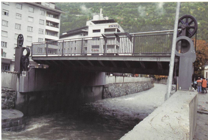
Bild 11. Hubbrücke über die Saltina in Brig-Glis in gehobenem Zustand (Aufnahme am 17. Oktober 2000, zwei Tage nach dem Hochwasser).
