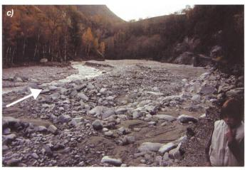
Bild 15. Obere Geschieberückhaltekammer im «Grindji: a) Zustand vor dem Hochwasser; b) während des Hochwassers vom 14./15. Oktober 2000; c) Auffüllung nach dem Hochwasser. (Fotos: André Burkard, Brig)
