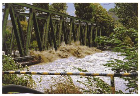
Bild 7. Auf Grund der verbreitet intensiven Niederschläge waren die Gerinne der Rhone und ihrer Zuflüsse auf der ganzen Länge bis an und teilweise über die Kapazitätsgrenze belastet, wie dieses Bild der Rhonebrücke bei Chippis eindrücklich belegt (Foto: Alusuisse).
