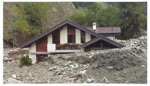
Bild 5. Zu den finanziell schwersten Schäden im Kanton Wallis kam es während des Oktober-Hochwassers in der Gemeinde Baltschieder. Gesamthaft lagerte der Hochwasser führende Baltschiederbach 150 000 bis 200 000 m³ Material im Dorfbereich ab.
