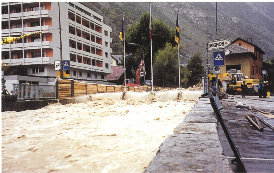
Bild 6. Mobile Elemente aus Stahlträgern und Dammbalken.
