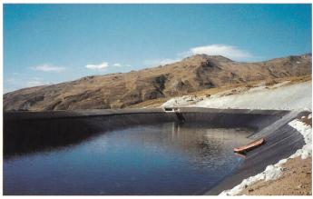
Bild 2. Abdichtung und Asphaltbeton. Speicherbecken Alp Dado GR während des Ersteinstaus. In Bildmitte sind das Einlaufbauwerk und die Hochwasserentlastung sichtbar. Rechts unten erscheint noch ein Stück der begrünten Beckenumrandung, welche den obersten, über dem Wasserspiegel liegenden Böschungsabschnitt bildet (Foto: R. Müller).
