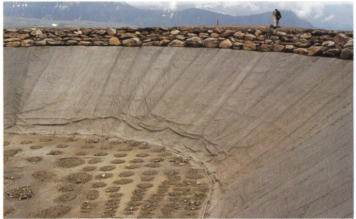
Bild 4. Abwärtsbewegung und Bildung von Falten bei einer Geomembrane infolge äusserer Einflüsse, wie Wind, Wellen, Schnee oder Eis (Foto: R. Müller).
