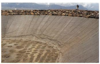
Bild 4. Abwärtsbewegung und Bildung von Falten bei einer Geomembrane infolge äusserer Einflüsse, wie Wind, Wellen, Schnee oder Eis (Foto: R. Müller).
