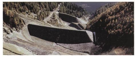
Bild 6. Lawinenauffangdämme im Val Varuna GR. Der oberliegende Damm (in Bildmitte) von 220 m Länge und 50 m Höhe weist eine zentrale Durchlassöffnung und am rechten Widerlager eine tief eingeschnittene Hochwasserentlastung auf. Der unterliegende Damm (oben rechts) besteht aus zwei sich überlappenden Halbdämmen, um die der Bach offen herumgeführt wird (Foto: Hegland + Partner AG, Chur).
