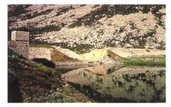
Bild 1. Ausbildung einer trapezförmigen Bresche infolge Bruchs eines Erddammes (Pianboglio, I).
