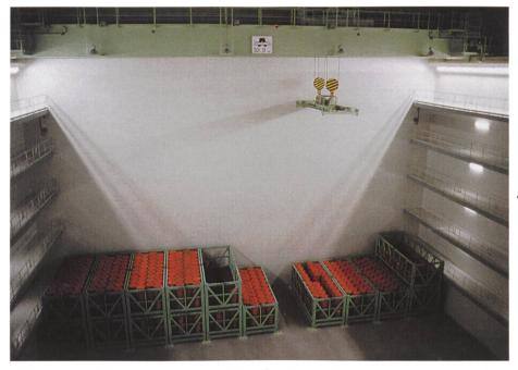
Bilder 1 und 2. Teile des heute knapp 1000 m³ umfassenden Lagerbestandes an radioaktiven Betriebsabfällen im Kernkraftwerk Beznau. Jedes Abfallgebinde ist minutiös inventarisiert, in seiner chemischen und radiologischen Zusammensetzung erfasst und sicher untergebracht (Bild 1). Der Kranführer beschickt das Lager mittels Fernbedienung in einem geschützten Nebenraum (Bild 2).
