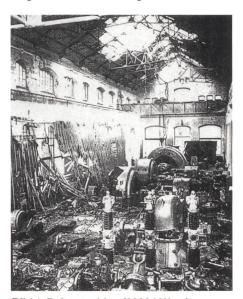
Bild 1. Peltonturbine (6000 kW, mit Generator, 7200 kVA, 600 min<sup>-1</sup>) auf Überdrehzahl gekommen, Generator auseinandergeflogen. (Bild und Legende aus: Allianz-Handbuch der Schadenverhütung)
