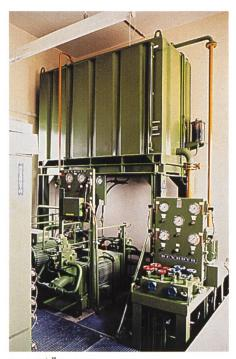
Bild 10. Ölbehälter mit darunter angeordneten Pumpengruppen.
