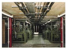
Bild 11. Hydraulikstation mit Verrohrungsaufbau.
