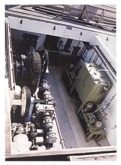
Bild 14. Vergleich Raumbedarf hydraulische und mechanische Antriebssysteme.
