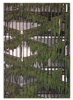
Bild 2. Grosse Rechenverluste durch Verstopfung an den Quertraversen.
