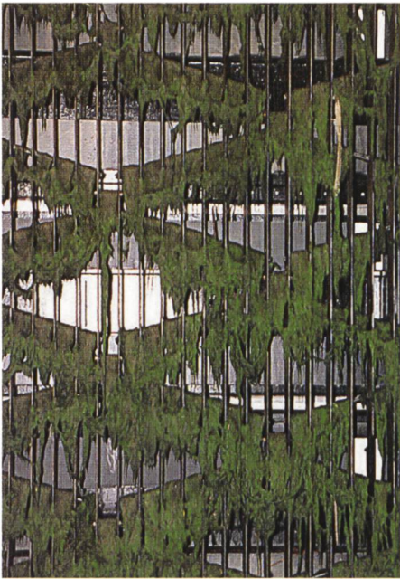
Bild 2. Grosse Rechenverluste durch Verstopfung an den Quertraversen.
