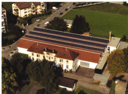
Bild 1. 2500 Solarschieferelemente sind im Dach der Zwicky-Fabrik, Fällanden, integriert.
