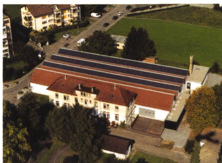
Bild 1. 2500 Solarschieferelemente sind im Dach der Zwicki-Fabrik, Fällanden, integriert.
