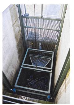
Bild 5. Fangkorb in unterster Position.
