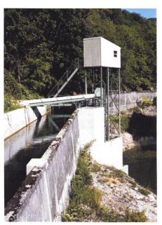
Bild 2. Ansicht von Oberwasser mit Abschwemmleitung.
