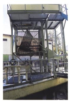
Bild 4. Fangkorb in Entleerposition.
