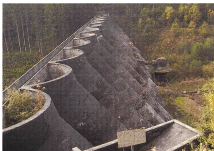
Bild 1. Wassenseite der Staumauer.
