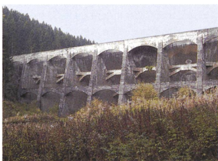
Bild 2. Ansicht der Staumauer (Unterwasserseite).
