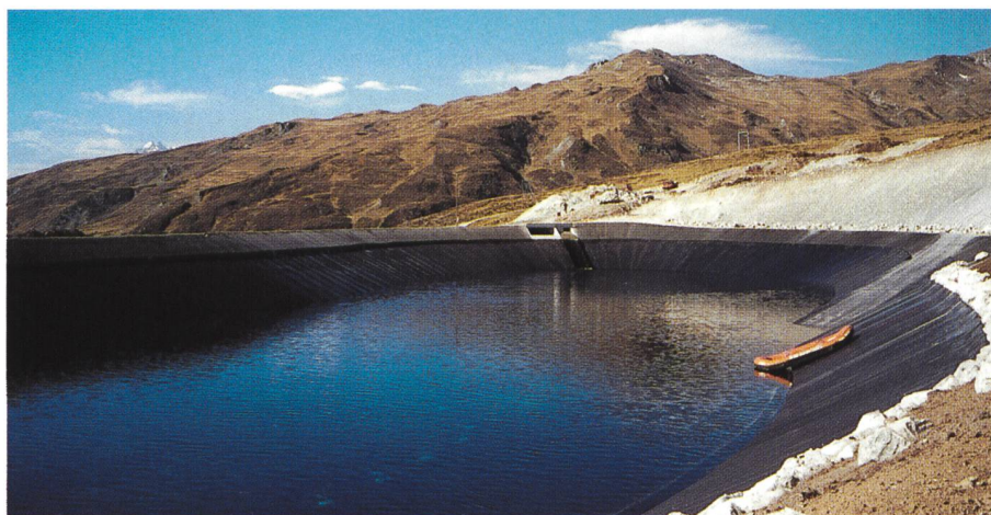
Figure 2. Masque en béton bitumineux. Bassin d'accumulation d'Alp Dado GR pendant la phase du premier remplissage. Au centre de l'image, la prise d'eau et l'évacuateur de crue sont visibles. A droite, on distingue une partie du pourtour engazonné du bassin, lequel forme la partie supérieure du talus au dessus du plan d'eau (photo: R. Müller).
