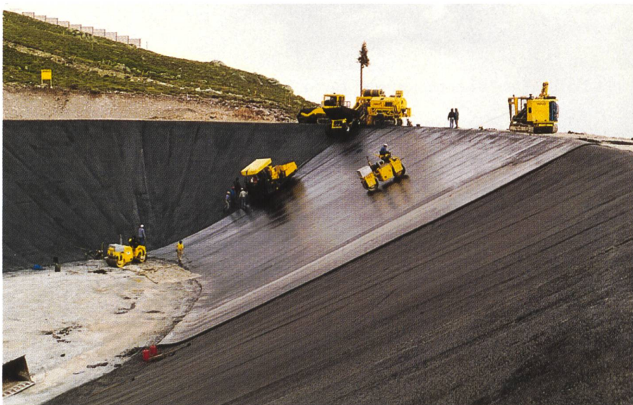
Bild 3. Belageinbau.
