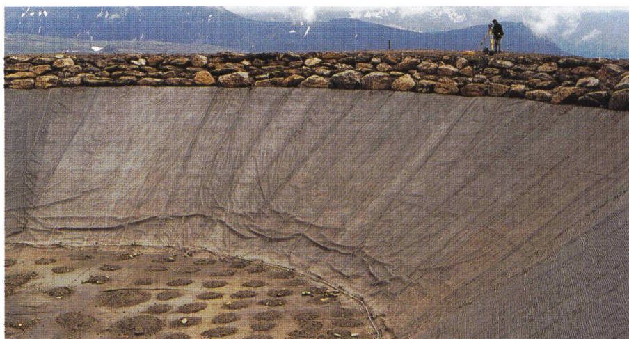
Figure 4. Mouvement vers la partie inférieure du talus d'une géomembrane, avec formation d'ondulations, suite à des effets extérieurs comme le vent, les vagues, la neige ou la glace (photo: R. Müller).
