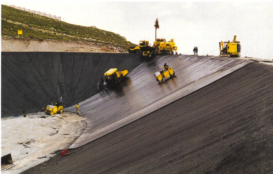
Bild 3. Belageinbau.
