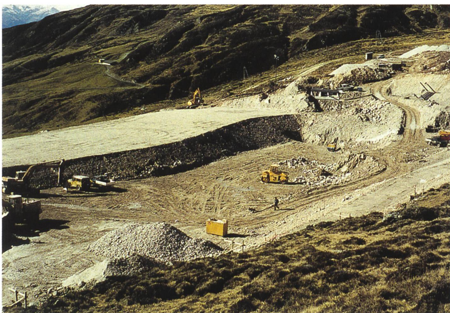
Bild 2. Erdarbeiten für das Becken.
