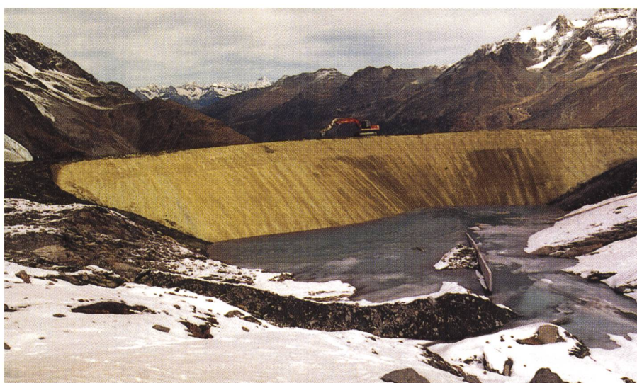
Figure 5. Revêtement du talus amont avec un sol stabilisé pour l'aménagement de production de neige artificielle de Othmarhang à Saas Fee VS (photo: A. Kobelt).
