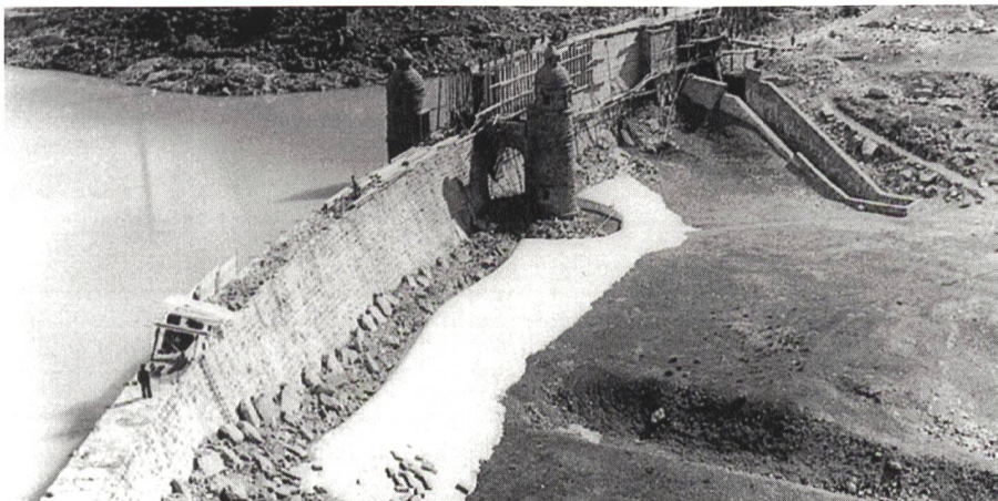
Mauer Scala: Erhöhung der Mauer in den Jahren 1941/42.
