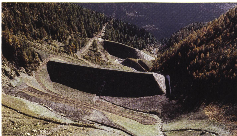
Figure 6. Ouvrage de protection contre les avalanches de Val Varuna GR. La digue supérieure d'une longueur de 220 m et d'une hauteur de 50 m (au milieu de l'image) comprend une ouverture centrale et un évacuateur de crue profond sur rive droite. La digue inférieure (en haut, à droite) est construite en deux parties légèrement superposées pour permettre le détournement du ruisseau à ciel ouvert (photo: Hegland + Partner AG, Chur).
