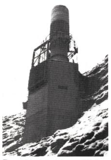
Figure 7. Prise flottante barrage Z'Mutt.
