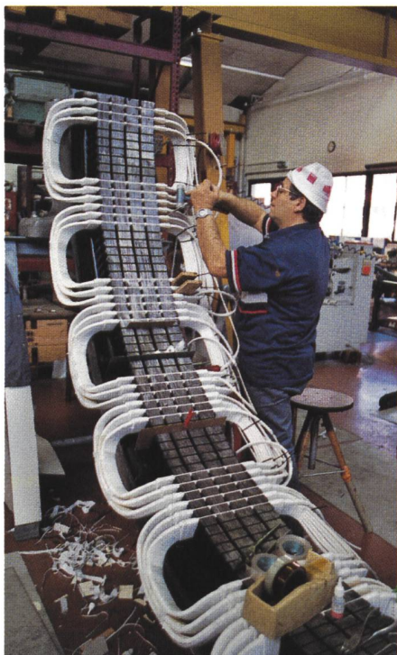
Bild 6. Die neue Generatorstatorwicklung wird in aufwendiger Handarbeit in die Nuten eingelegt.
