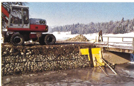
Bild 3. Zur Reparatur der abgerutschten Böschungen des Oberwasserkanals werden Steinkörbe eingesetzt (links).
