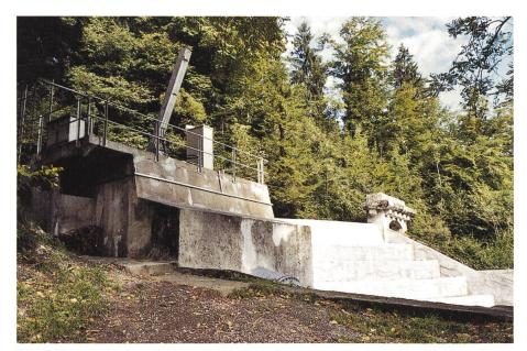
Bild 8. Kraftwerkseinlauf mit neuer Rechenreinigungsmaschine und seitlichem Überfall zur Wasserentlastung bei zu hohem Kanalpegel.
