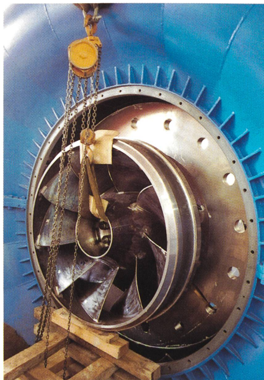
Bild 5. Die Turbinenwelle mit dem neuen Francis-Laufrad wird in die Einlaufspirale eingebaut.
