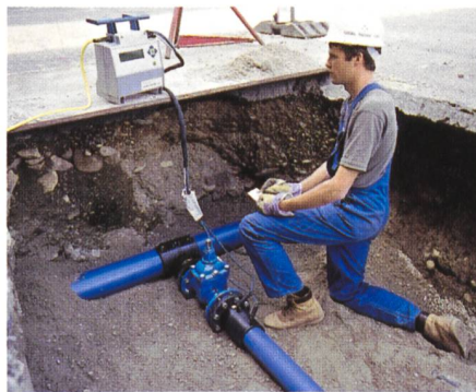
Bild 1. Elektroschweisbare Anschlussschelle des Systems ELGEF Plus.
