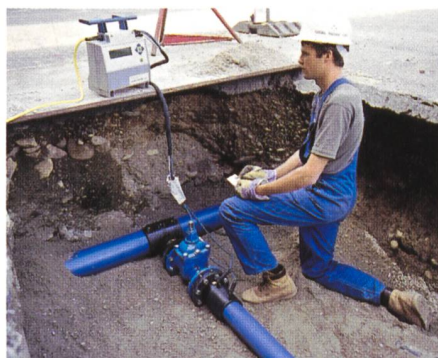
Bild 1. Elektroschweiszbare Anschlussschelle des Systems ELGEF Plus.
