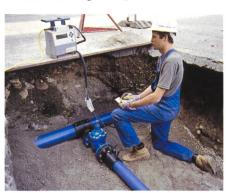
Bild 1. Elektroschweissbare Anschlussschelle des Systems ELGEF Plus.
