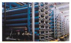
Bild 1. Palma de Mallorca: Entsalzungsanlage nach dem Verfahren der Umkehrosmose mit einer Kapazität von 39 000 m³/Tag (Quelle: Degrémont).
