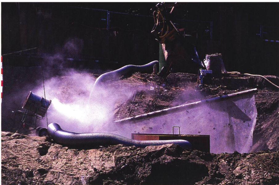
Bild 6. Sanierung der Säureharzdeponie Tössegg: Das gezielte Besprühen mit Wasserdampf verhindert die Emission von Geruchspartikeln.
