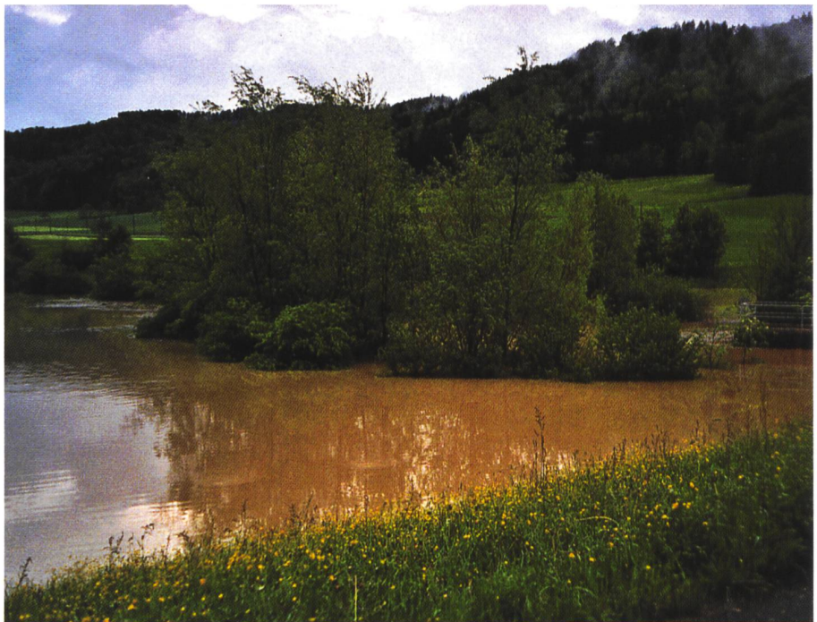
Bild 3. Hochwasserrückhaltebecken am Chatzenbach: Das Hochwasserrückhaltebecken staut nach starken Regenfällen das Wasser und leitet es dosiert ab.
