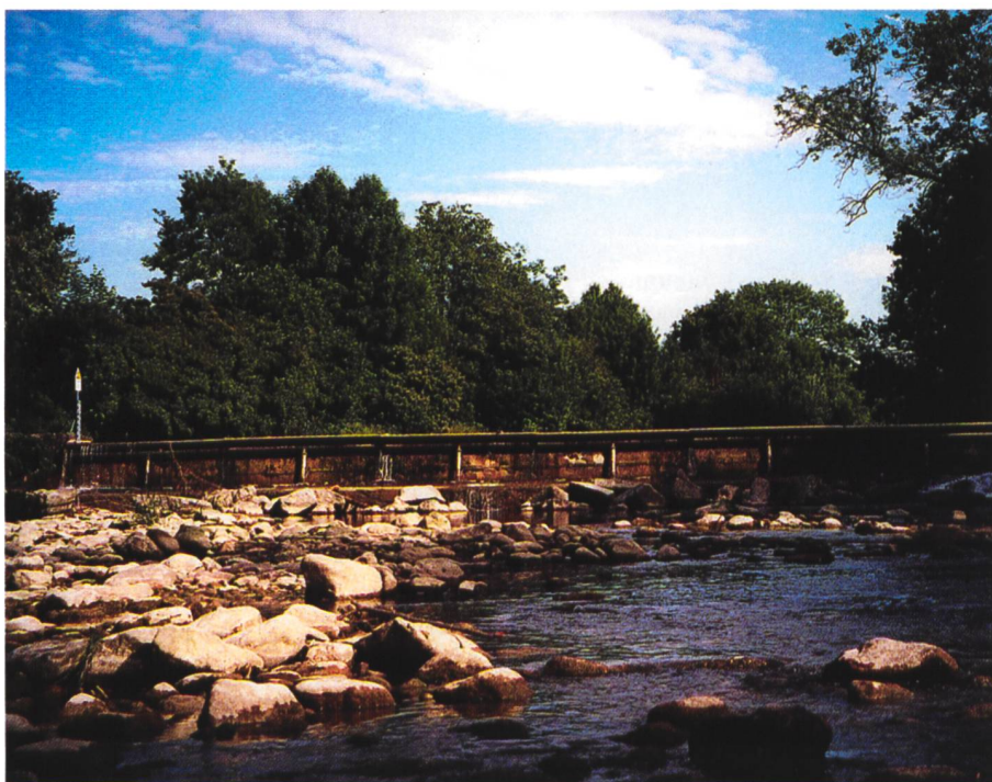
Bild 5. Kleinkraftwerk Hard in Winterthur-Wülflingen: Das Stauwehr stellt eine ökologisch verträgliche Restwassermenge sicher.
