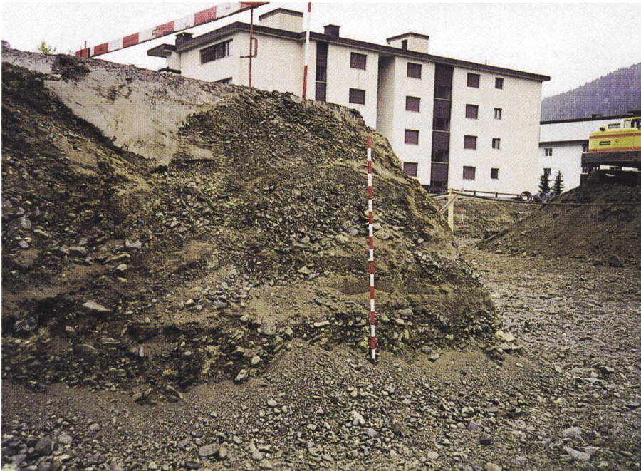
Bild 4. Aufschluss und Kartierung alter Überschwemmungssedimente anlässlich einer Baugrube, Davos, 1998.
