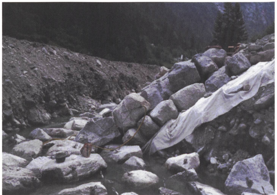
Bild 16. Doppellagig auf Geotextil verlegter Blockwurf im Bau. Fussblöcke sind zum gegenseitigen Verbinden mit Stahlseilen mit Schlaudern versehen (Blockgewicht 4,0 bis 4,5 t). Links Schutzdamm für die Wasserhaltung.
