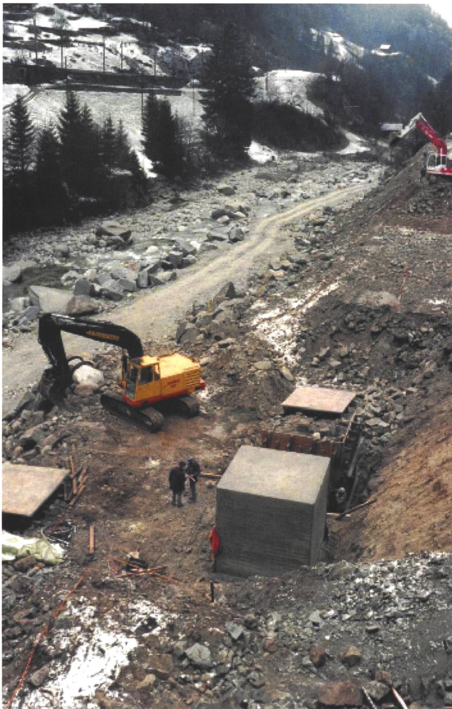
Bild 20. Erstellung der diagonal getrennten Betonwürfel (Gurnellen – Gütli, Kanton Uri).
