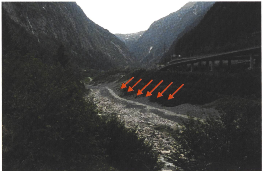
Bild 21. Überschüttete Blockbühnen an der Reuss (Göschenen – Teufelstein, Kanton Uri).
