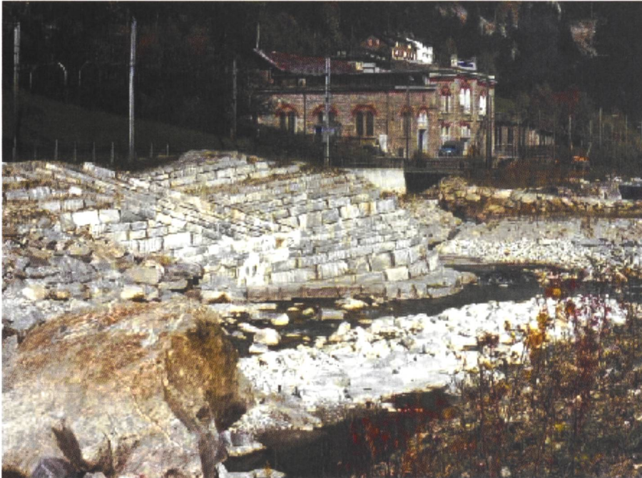
Bild 25. Künstlicher Umlenksporn ein Jahr nach der Erstellung (Gurtellen-Wiler, Kanton Uri).
