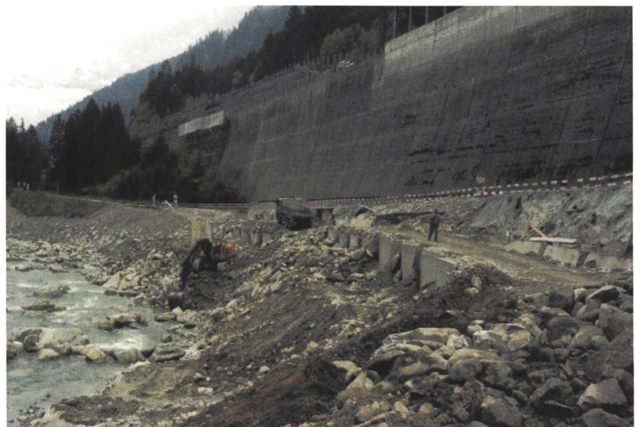
Bild 19. Eingegrabene, diagonal getrennte Betonwürfel als linienförmiger Uferschutz an der Reuss (Gurtellen – Gütli, Kanton Uri).
