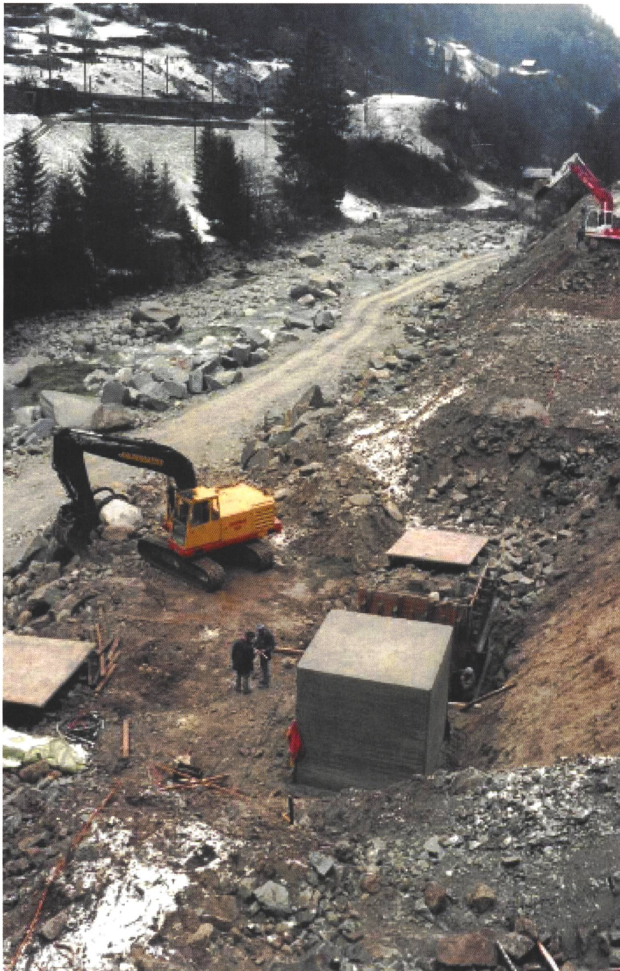
Bild 20. Erstellung der diagonal getrennten Betonwürfel (Gurtellen – Gütli, Kanton Uri).
