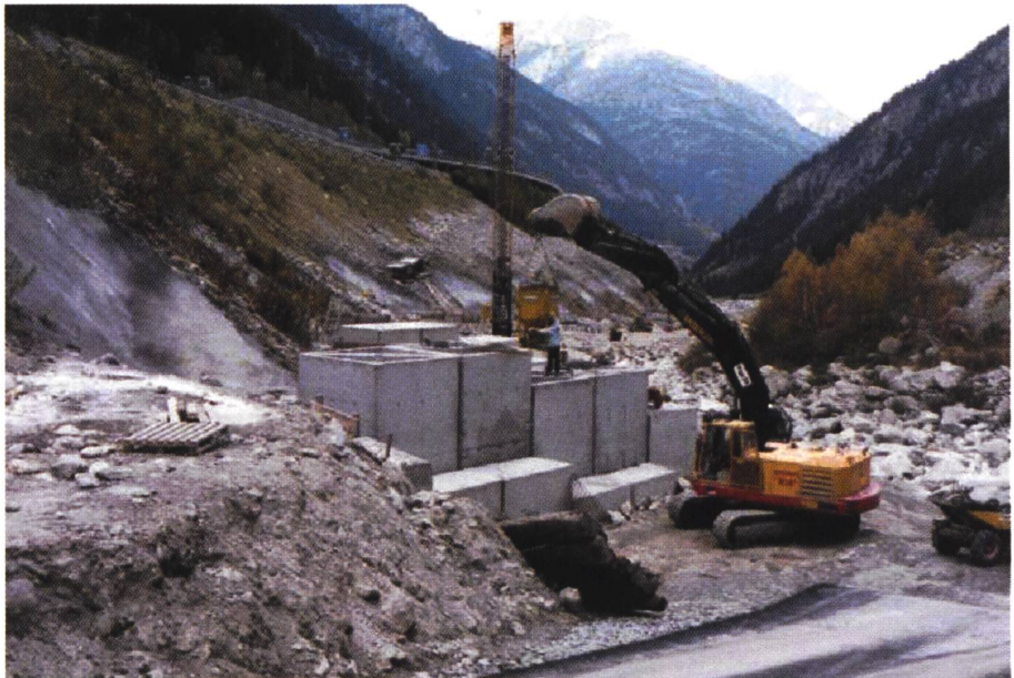
Bild 22. Umlenkbuhnen aus diagonal getrennten Betonwürfeln an der Reuss (Göschenen – Teufelstein, Kanton Uri) [7].
