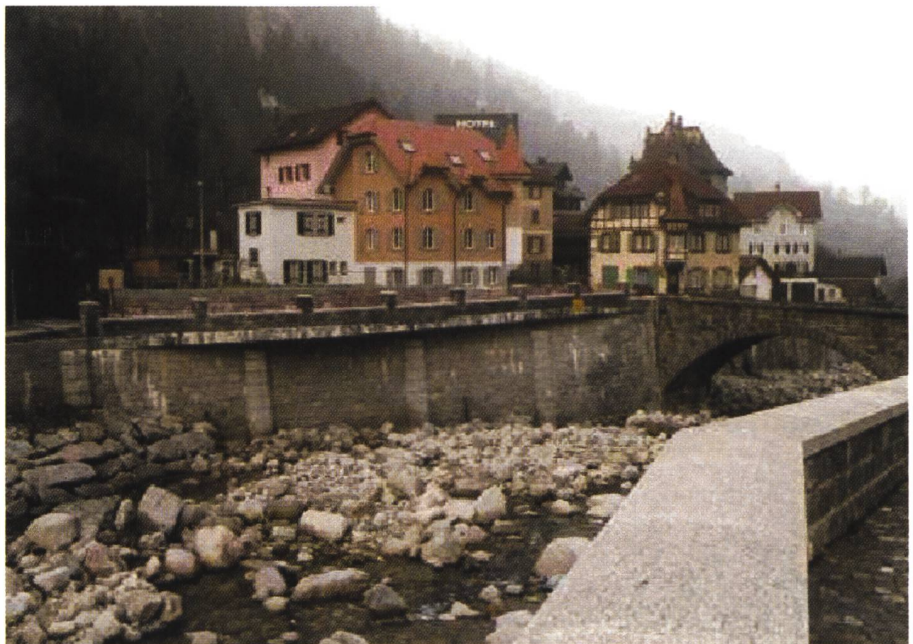
Bild 5. Winkelstützmauer mit vertikalen Rauigkeitsrippen aus trapezförmig gebrochenen Steinblöcken (Gurtellen, Kanton Uri).
