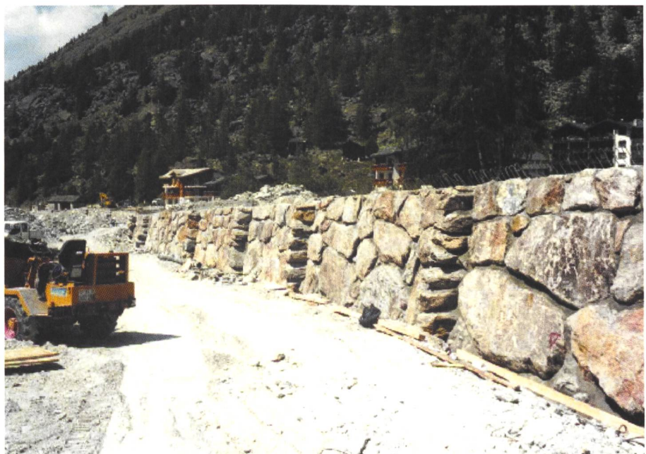
Bild 6. Winkelstützmauer mit vertikalen Rauigkeitsrippen aus unregelmässigen Blöcken (Saas-Almagell, Kanton Wallis).
