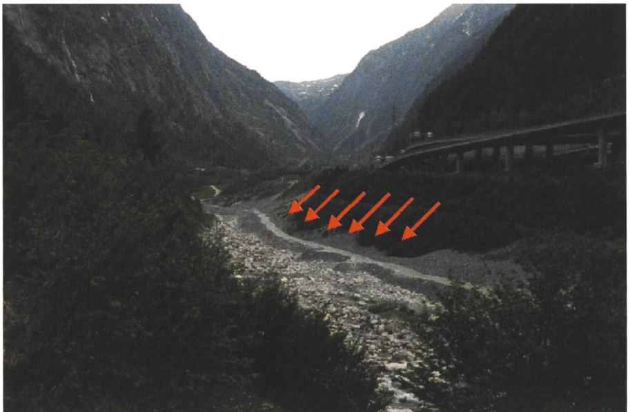
Bild 21. Überschüttete Blockbuhnen an der Reuss (Göschenen – Teufelstein, Kanton Uri).
