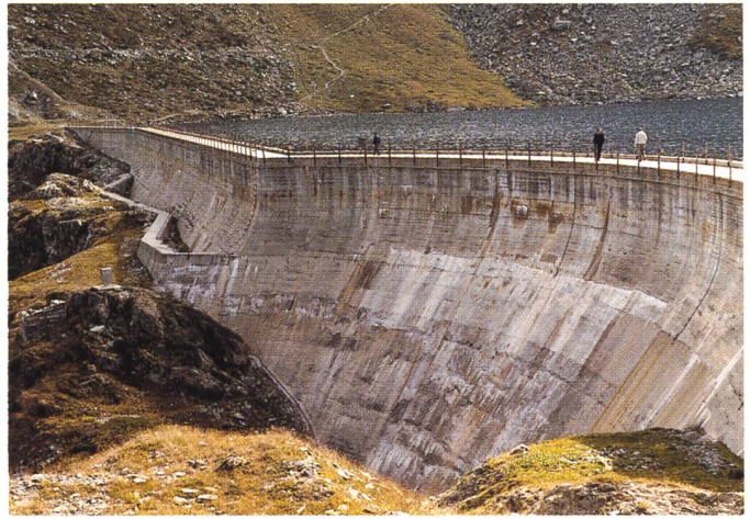
Figure 13. Barrage d'Illsee/Illsee dam.
