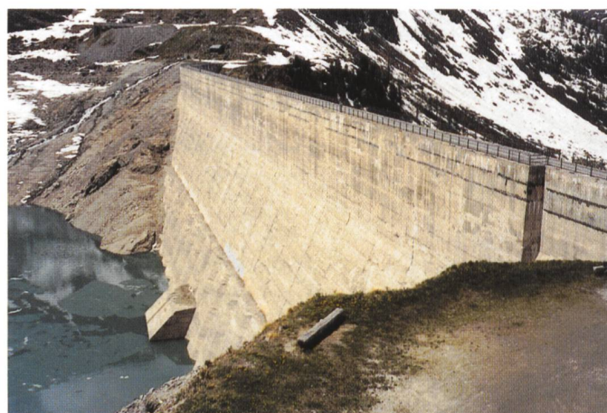
Figure 6. Barrage de Cleuson, vue du parement amont avant réparation.
