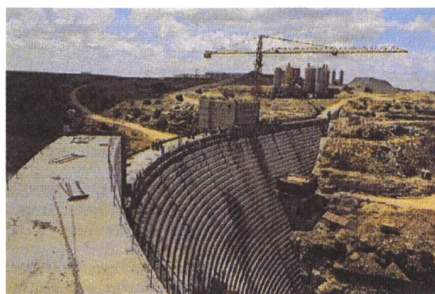
Figure 5. Construction en BCR du barrage de Knellpoort, Afrique du Sud. (Water Power & Dam Construction, novembre 1989)
