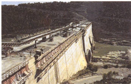
Figure 4. Construction en BCR du barrage de Rialb, Espagne. (Schleiss, A., 1998)
