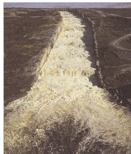
Figure 6. Evacuateur de crue en cascade de la Grande, Canada 1984.
