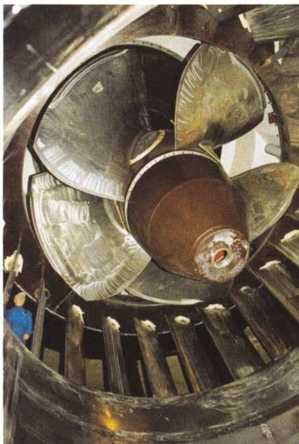
Bild 8. Kraftwerk Wildegg-Brugg: Turbine 2: Neue rostfreie Leitschaufeln und neues Laufrad.
