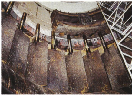
Bild 7. Kraftwerk Wildegg-Brugg: Turbine 1: Demontage der alten Leitschaufeln.
