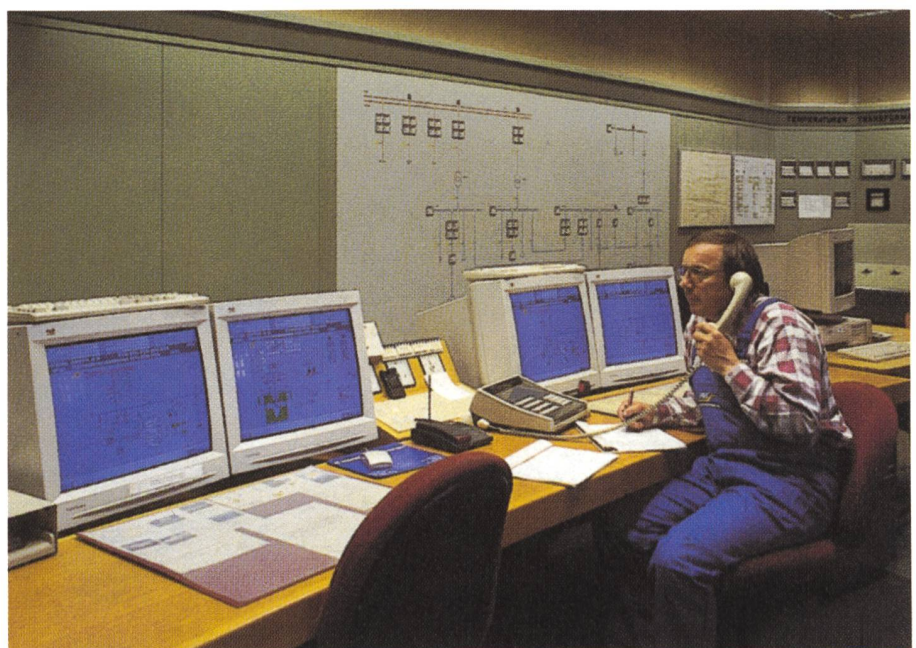
Bild 21. Kraftwerk Wildegg-Brugg: Neues Bediensystem im bestehenden Kommandoraum.
