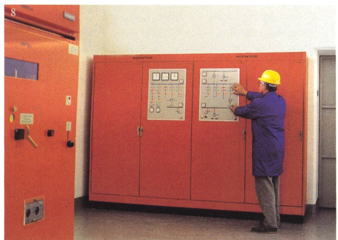
Bild 17. Kraftwerk Wildegg-Brugg: Nebensteuerstelle der Eigenbedarfs-Schaltanlage.
