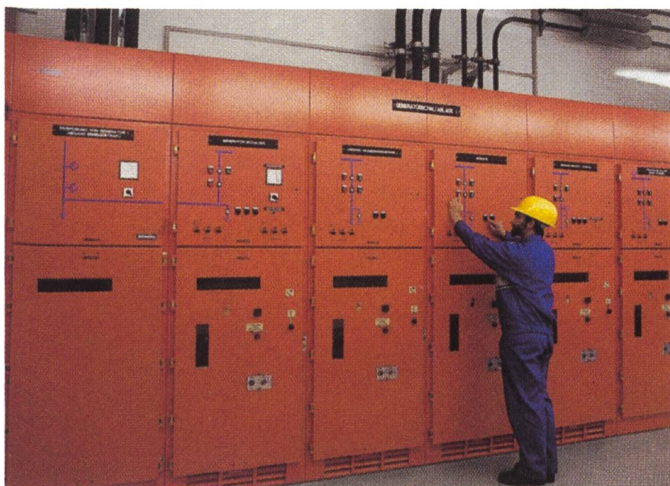
Bild 16. Kraftwerk Wildegg-Brugg: Neue, gekapselte 8-kV-Generator-Schaltanlage.
