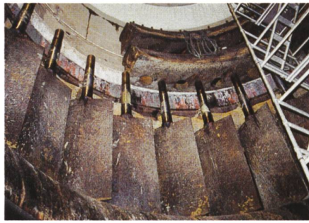
Bild 7. Kraftwerk Wildegg-Brugg: Turbine 1: Demontage der alten Leitschaufeln.
