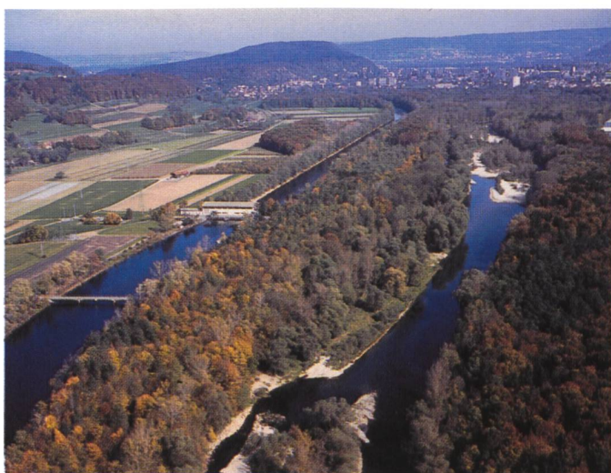
Bild 2. Kraftwerk Wildegg-Brugg: Teil des Konzessionsgebietes bei Villnachern mit Zentrale und altem Aarelauf.
