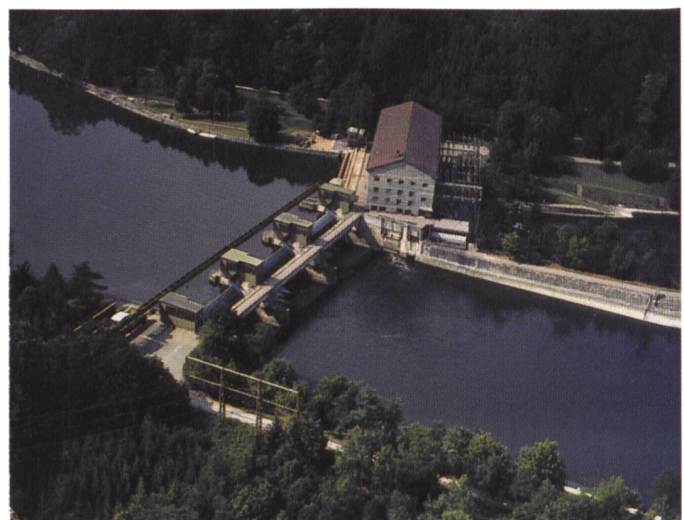
Bild 3. Kraftwerk Rapperswil-Auenstein: Stauwehr und Maschinenhaus.
