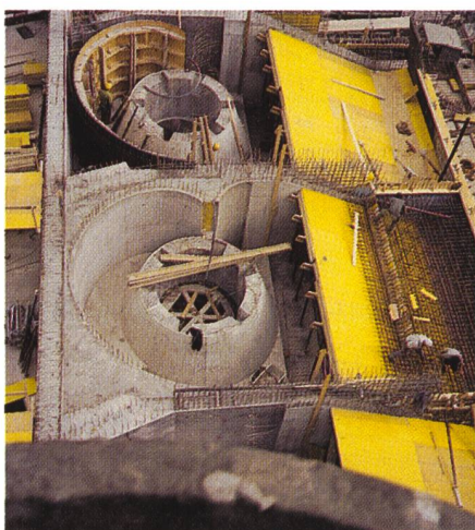
Bild 5. Einlaufspiralen.
