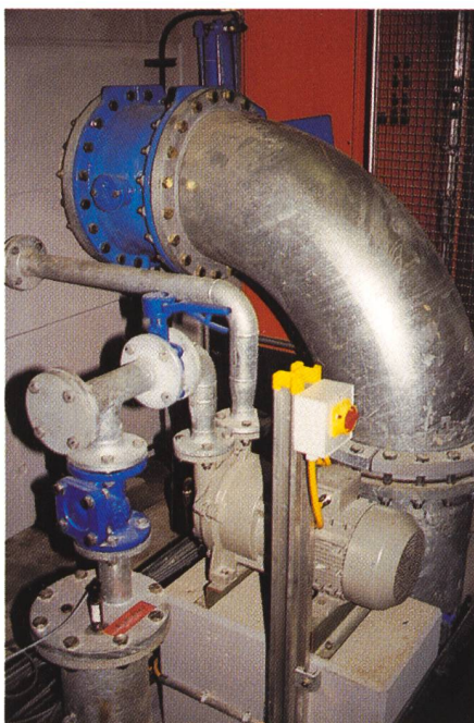
Bild 4. Standardpumpe für den Turbinen-anlauf.
