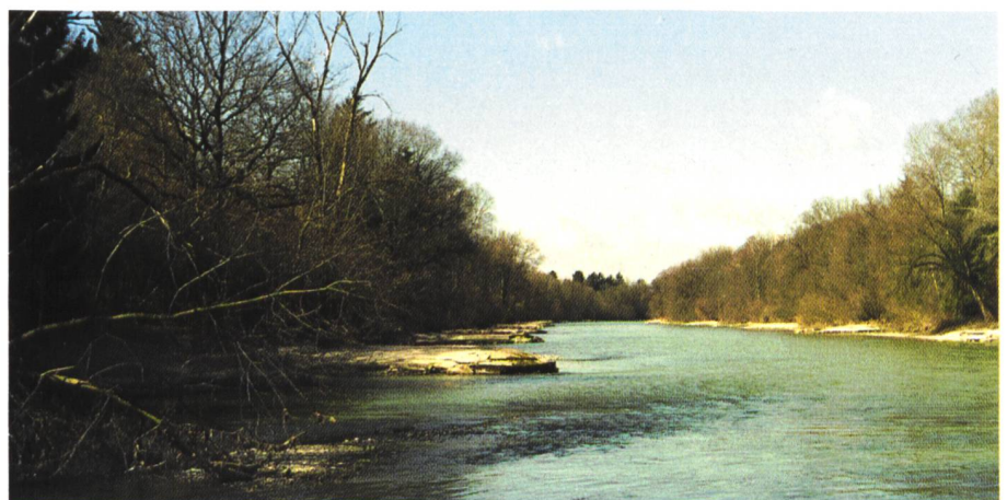
Bild 11. Buhnen an der Aare, aufgebaut aus Kies und Blöcken mit Oberflächenschutz aus Beton (Blick in Fließrichtung).
