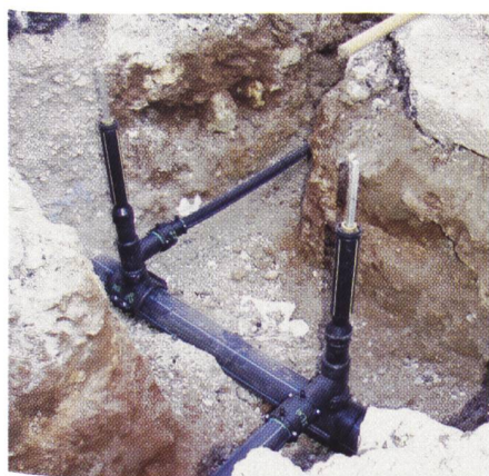
Bild 1. Elektroschweiszbare, korrosionsfreie Druckerbohrventile komplett aus Kunststoff mit einem 360° einstellbaren Abgangsstützen. Damit kann jede Anpassung der Anschlussrichtung ohne zusätzliche Fittings vorgenommen werden.
