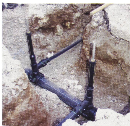
Bild 1. Elektroschweisssbare, korrosionsfreie Druckanbohrventile komplett aus Kunststoff mit einem 360° einstellbaren Abgangsstutzen. Damit kann jede Anpassung der Anschlussrichtung ohne zusätzliche Fittings vorgenommen werden.
