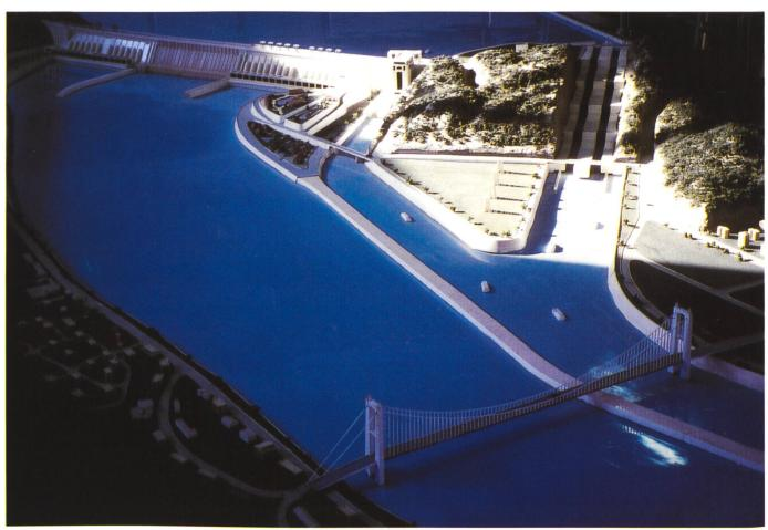
Bild 1. Modell des Drei-Schluchten-Projekts am Yangtse mit Staumauer, beidseitigen Wasserkraftwerken und Schleusen (rechts).
