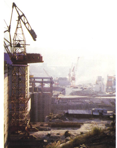
Bild 5. Schiffshebewerk im Bau und Betonmischanlage (rechts).
