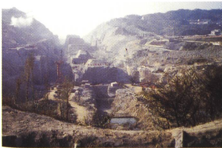
Bild 4. Gebirgsabtrag für den Bau der Schleusenanlage.
