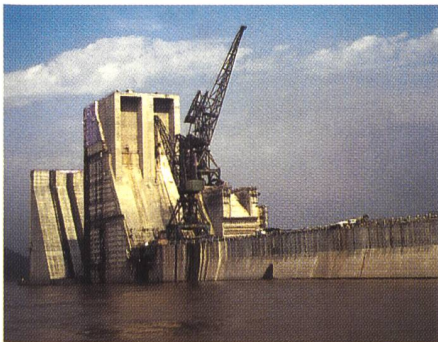
Bild 3. Teil der Staumauer im Yangtse.
