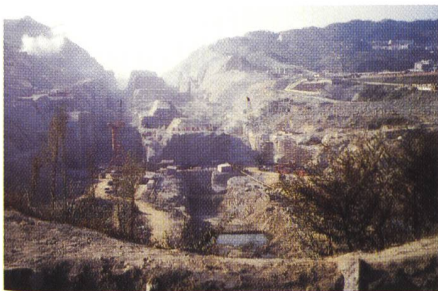
Bild 4. Gebirgsabtrag für den Bau der Schleusenanlage.
