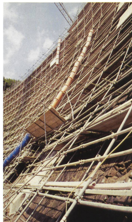
Bild 2. Detailaufnahme der Gerüstung auf der Luftseite.
