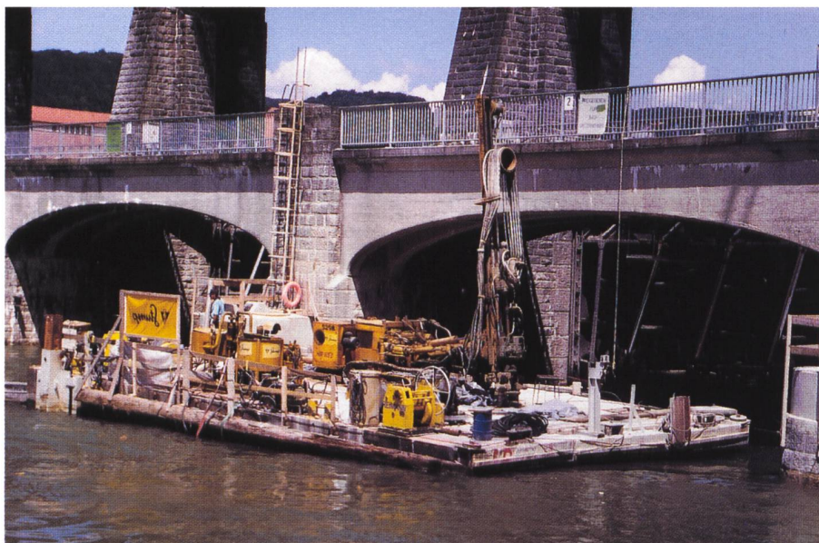
Bild 5. Floss für Bohrarbeiten und Installation von Mikropfählen.
