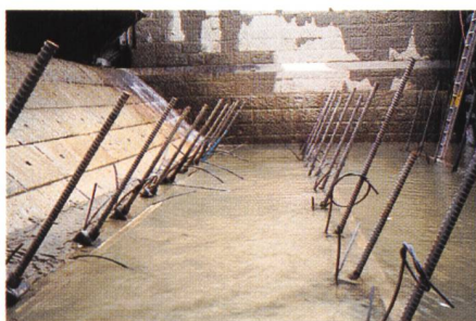
Bild 8. Mikropfähle in Sohle nach Entleerung.
