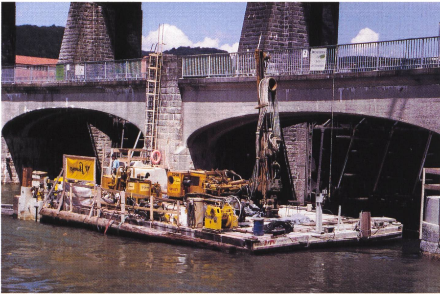
Bild 5. Floss für Bohrarbeiten und Installation von Mikropfählen.
