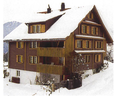
Bild 1. Eines der fünf im Rahmen von Energie 2000 an der Hülle sanierten Gebäude in der Gemeinde Oberberg.
