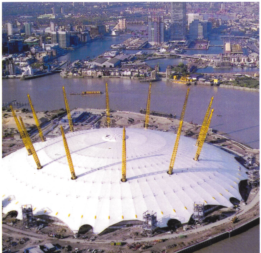
Millennium Dome, eine Ausstellungshalle zu Ehren des neuen Jahrhunderts – ein 50 m hoher Kuppelbau von 320 m Durchmesser mit zwölf 100 m hohen Stahlgittermasten für das abgespannte Dach aus kunststoffbeschichtetem Glasfasergewebe.
