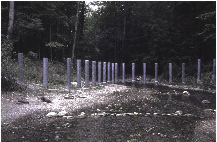
Bild 2. V-förmiger Schwemmholzfäng am Chämtnerbach/Kanton Zürich im ausgeräumten Zustand (Blick in Fliessrichtung; Bildnachweis: Amt für Abfall, Wasser, Energie und Luft des Kantons Zürich).
