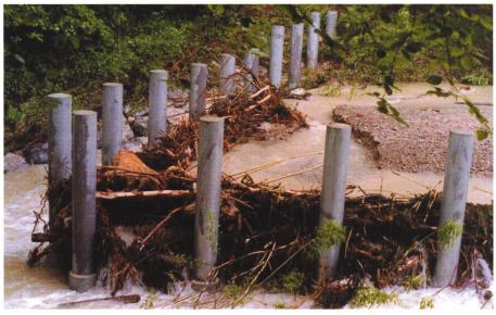
Bild 3. Beaufschlagter V-förmiger Schwemmholzfang am Chämtnerbach/Kanton Zürich nach dem Hochwasser vom 13. Mai 1999 (Fliessrichtung von rechts; Bildnachweis: Amt für Abfall, Wasser, Energie und Luft des Kantons Zürich).
