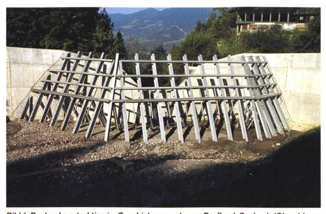
Bild 1. Rechenkonstruktion im Geschiebesammler am Dorfbach Sachseln/Obwalden (Blick in Fliessrichtung).
