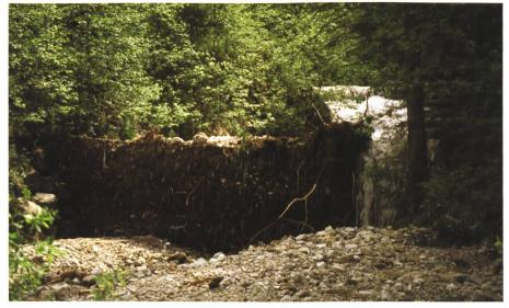
Bild 5. Beaufschlagtes Schwemmholznetz am Faukengraben/Oberbayern (Blick entgegen der Fliessrichtung; Bildnachweis: VAO).
