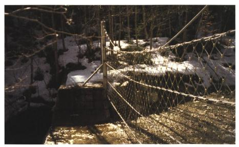
Bild 4. Schwemmholznetz am Lahnenwiesgraben/Oberbayern (Fliessrichtung von rechts; Bildnachweis: Versuchsanstalt für Wasserbau und Wasserwirtschaft der TU München, VAO).
