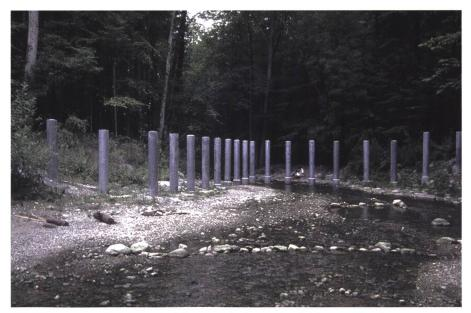
Bild 2. V-förmiger Schwemmholzfang am Chämtnerbach/Kanton Zürich im ausgeräumten Zustand (Blick in Fliessrichtung; Bildnachweis: Amt für Abfall, Wasser, Energie und Luft des Kantons Zürich).
