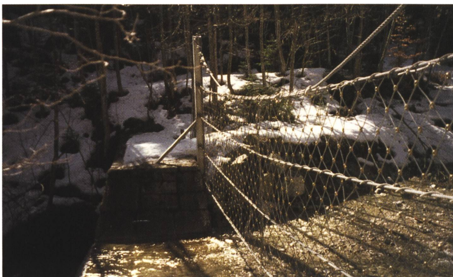
Bild 4. Schwemmholznetz am Lahnenwiesgraben/Oberbayern (Fließrichtung von rechts; Bildnachweis: Versuchsanstalt für Wasserbau und Wasserwirtschaft der TU München, VAO).
