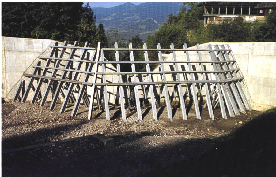
Bild 1. Rechenkonstruktion im Geschiebesammler am Dorfbach Sachseln/Obwalden (Blick in Fliessrichtung).
