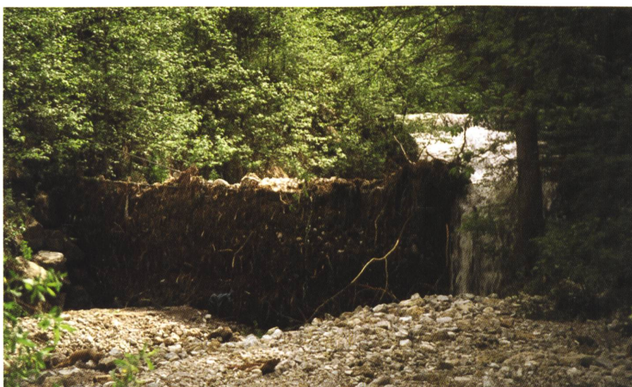
Bild 5. Beaufschlagtes Schwemmholznetz am Faulengraben/Oberbayern (Blick entgegen der Fließrichtung; Bildnachweis: VAO).
