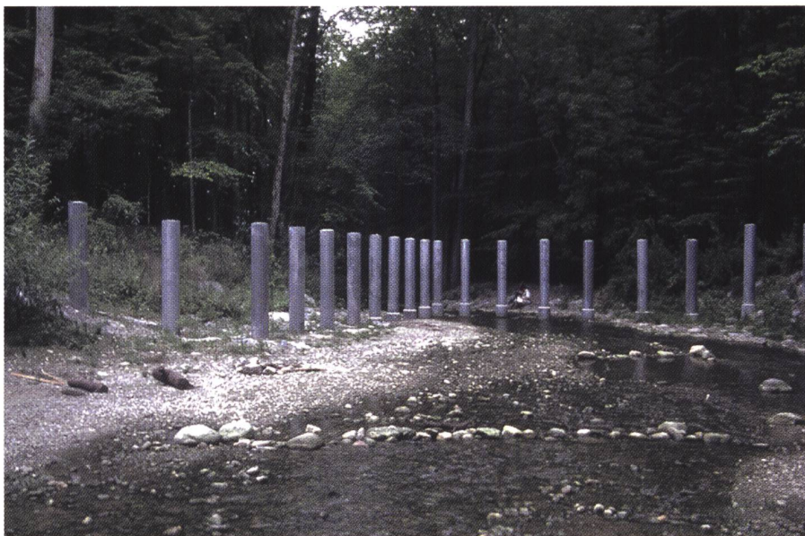
Bild 2. V-förmiger Schwemmholtzfänger am Chämtnerbach/Kanton Zürich im ausgeräumten Zustand (Blick in Fliessrichtung; Bildnachweis: Amt für Abfall, Wasser, Energie und Luft des Kantons Zürich).
