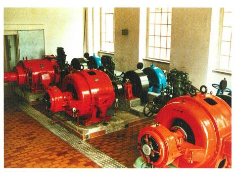
Bild 1. Die drei alten, eindüsigen Peltonmaschinen waren noch mit hydraulischen Reglern ausgestattet.
