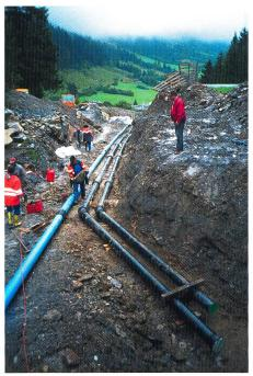
Bild 6. In den Druckleitungsgraben wurden zusätzlich eine Hochdruckleitung für die Beschneiungsanlage und streckenweise noch Trinkwasserleitungen verlegt.
