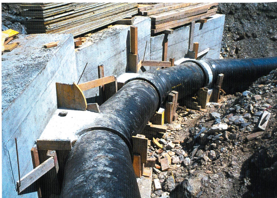
Bild 4. Das massive Betonwiderlager nimmt am Knickpunkt die riesige Auslenkkraft der Druckleitung auf. Nach dem Auffüllen ist von allem nichts mehr zu sehen.
