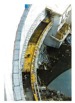
Bild 6. Erstellung der neuen Bedienungsgalerie. Schalung und Betonierarbeiten der Sohle (Stand am 14. Oktober 1999).
