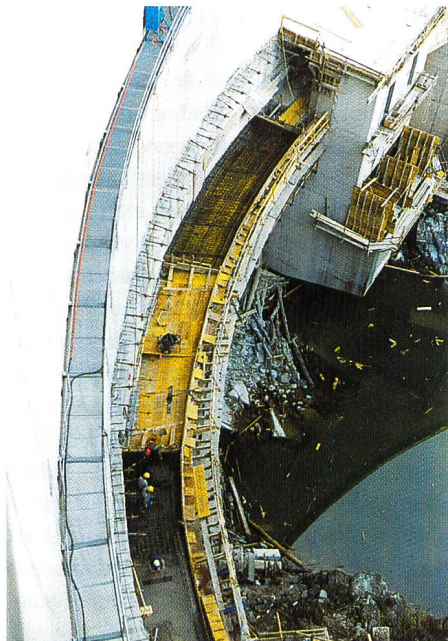
Bild 6. Erstellung der neuen Bedienungsgalerie. Schalung und Betonierarbeiten der Sohle (Stand am 14. Oktober 1999).
