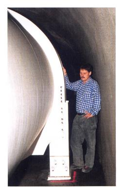
Bild 5. Auflagersattel im Rohrstollen mit höhenverstellbaren Füssen und Gleitlager unter den Fussplatten.
