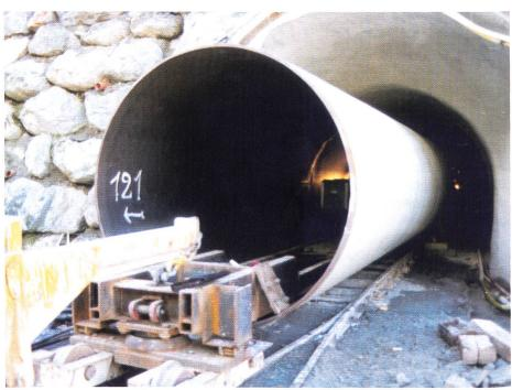
Bild 11. Transport der 12 m langen Rohre für den Rohrstollen. Der Aussenkorrosionsschutz wurde schon im Werk aufgebracht.
