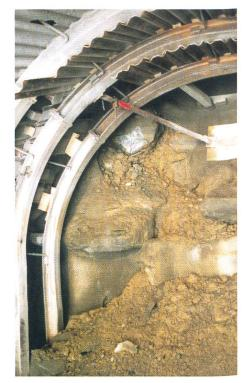
Bild 2. Marciavanti-Vortrieb im Rohrstollen durch die Sackungsmasse.
