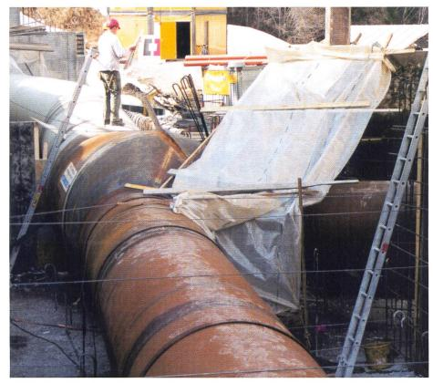
Bild 6. Anschlussbereich bei Zentrale. Im Vordergrund neuer Teil Verteilleitung mit Schalungen für Fixpunkt. Im Hintergrund Übergang Rohrkeller in den Rohrstollen.
