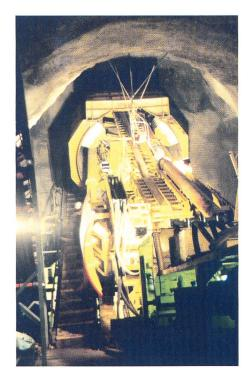
Bild 8. Einbau der Vortriebseinrichtung am Fuss des Schrägschachtes. Die Kavernengrösse war grösstenteils durch die angefahrene Karsthöhle gegeben.
