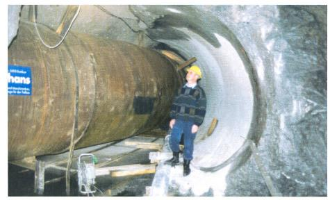
Bild 14. Übergang Panzerung Anschlussstollen in bestehenden Druckstollen Marmorera-Tinizong. Blick entgegen der Fliessrichtung. Gut sichtbar die angebrochene Betonverkleidung des bestehenden Stollens.
