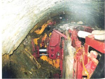
Bild 3, links. Händischer Vortrieb vor dem Fräskopf im unteren Druckstollen in der Triaszone. Sicherung mit Stahleinbau und Spritzbeton. Bild 4, rechts. Fräsvortrieb im unteren Druckstollen nach dem Einbruch. Die Fräse ist grösstenteils wieder freigelegt. Im linken Parament sind Rauhwackenbänke sichtbar, die ein Verspannen der Gripper massiv erschwerten.
