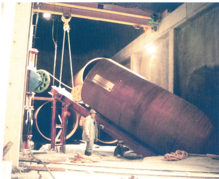
Bild 10. Rohrumschlag in der Kaverne für die Panzerungsmontage im Schrägschacht.
