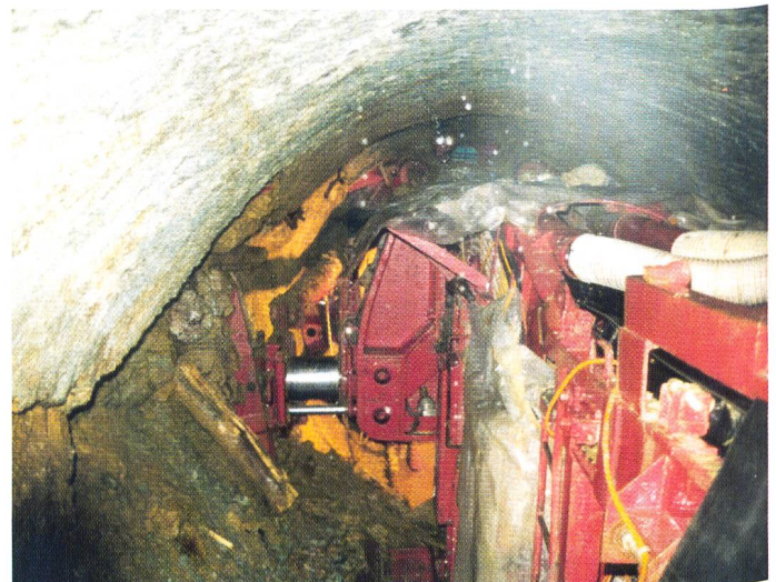
Bild 3, links. Händischer Vortrieb vor dem Fräskopf im unteren Druckstollen in der Triaszone. Sicherung mit Stahleinbau und Spritzbeton. Bild 4, rechts. Fräsvortrieb im unteren Druckstollen nach dem Einbruch. Die Fräse ist grösstenteils wieder freigelegt. Im linken Parament sind Rauhackebänke sichtbar, die ein Verspannen der Gripper massiv erschwerten.
