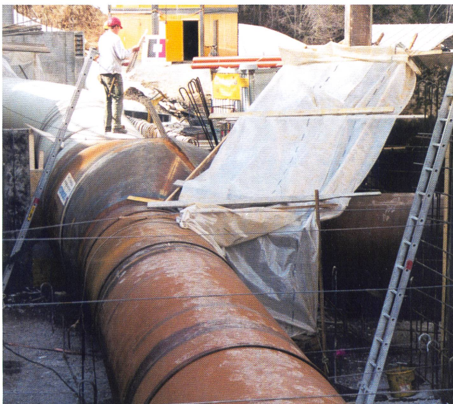
Bild 6. Anschlussbereich bei Zentrale. Im Vordergrund neuer Teil Verteilleitung mit Schalungen für Fixpunkt. Im Hintergrund Übergang Rohrkeller in den Rohrstillen.
