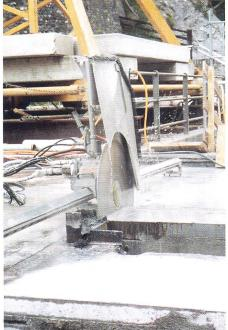
Bild 5, links. Luftseitige Ansicht der Abbrucharbeiten im linken Wehrfeld. Die Wehrbrücke im Feld I wurde bereits entfernt und der Wehrpfeiler I/II bis zur Mitte gekürzt. Zur Gewährleistung der Wehrpassage wurde eine Hilfsbrücke erstellt. Dabei diente die ausgebaute Grundablassschütze als Brückenplatte. Bild 6, rechts. Einsatz einer schienengeführten Betonfräse beim Abbruch der Wehrbrücke.
