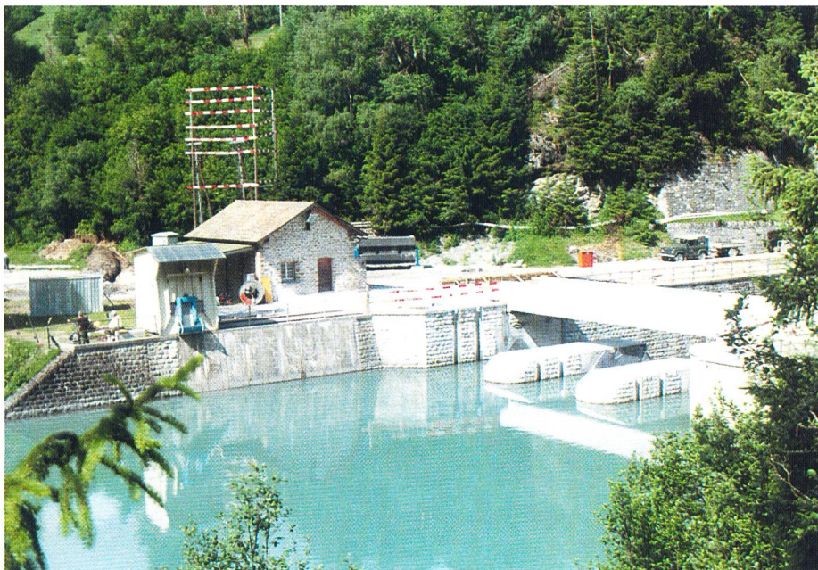
Bild 10. Wasserseitige Ansicht des umgebauten Wehres und des linken Widerlagers mit Rechenreiniger und Betriebsgebäude.
