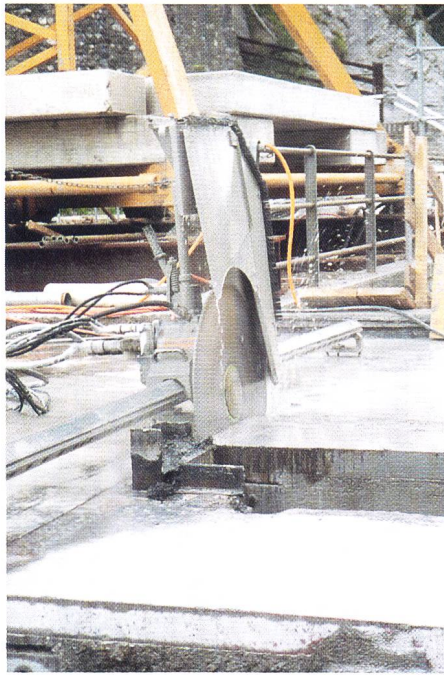
Bild 5, links. Luftseitige Ansicht der Abbrucharbeiten im linken Wehrfeld. Die Wehrrücke im Feld I wurde bereits entfernt und der Wehrpfeiler I/II bis zur Mitte gekürzt. Zur Gewährleistung der Wehrpassage wurde eine Hilfsbrücke erstellt. Dabei diente die ausgebaute Grundablassschütze als Brückenplatte. Bild 6, rechts. Einsatz einer schienengeführten Betonfräse beim Abbruch der Wehrrücke.
