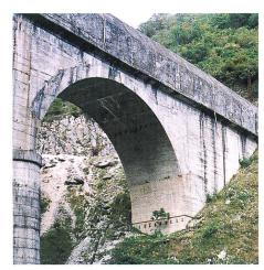
Bild 4. Talquerung des Druckstollens mit Stahlrohr auf Aquädukt.
