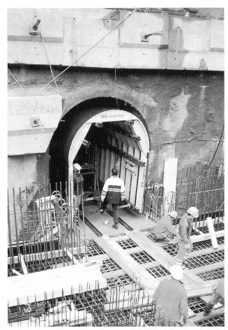
Figure 3. Le travail en galerie a consisté à créer un coffrage de 7,5 m de long en bois, et d'injecter ensuite un béton autocompactant. Cette opération s'est déroulée en onze étapes successives sur un mois.
