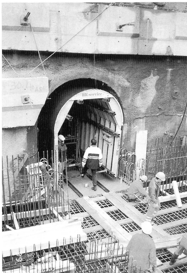
Figure 3. Le travail en galerie a consisté à créer un coffrage de 7,5 m de long en bois, et d'injecter ensuite un béton autocompactant. Cette opération s'est déroulée en onze étapes successives sur un mois.
