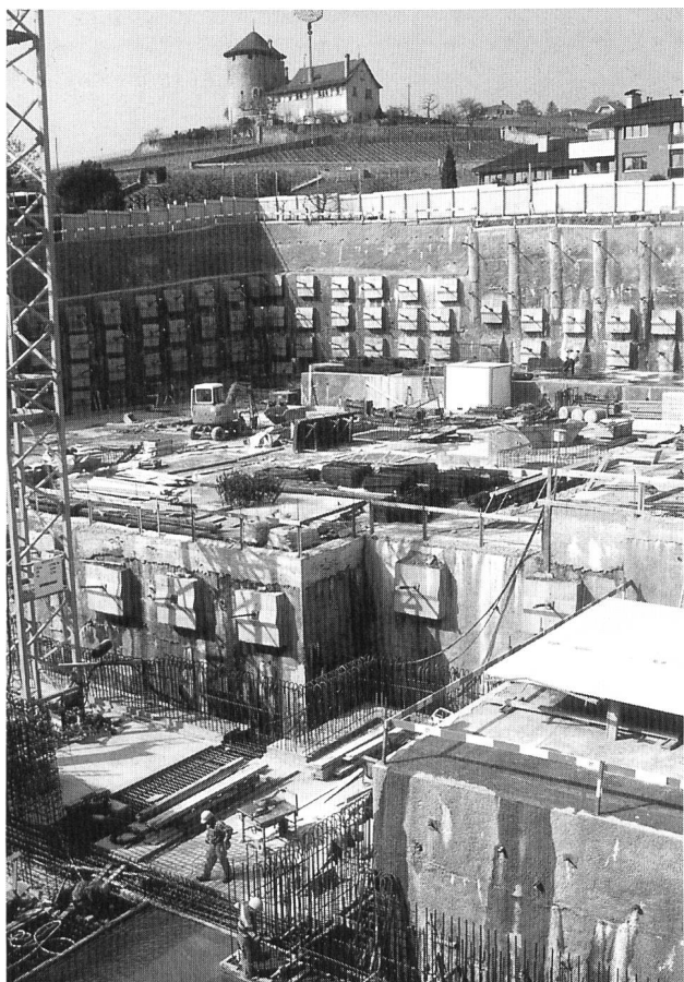
Figure 1. Avec la Tour Bertholoz, la station se trouve en plein site historique. Le Service des eaux de Lausanne était donc tenu de construire très profond. La solution a été d'opter pour une construction souterraine, c'est-à-dire qu'une fois l'usine achevée, seule une vigne sera visible, comme à l'origine. La galerie et le premier radier du bâtiment sont situés à 11 m au-dessous du niveau du lac Léman.
