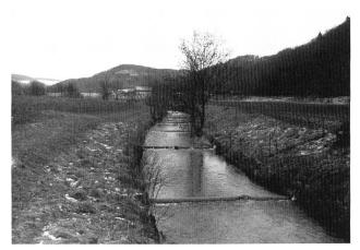
Bild 2. Monotoner Gewässerabschnitt im Landwirtschaftsgebiet: Die Gewässersohle ist mit Schwellen stabilisiert, der Böschungsfuss mit Betonplatten verbaut, das Umland intensiv genutzt.
