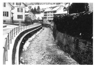
Bild 3. Vordere Frenke im Siedlungsgebiet: Der Fluss wurde kanalisiert, die Gewässersohle gepflastert. Die Vordere Frenke hat ihre Funktion als Lebensraum eingebüsst.
