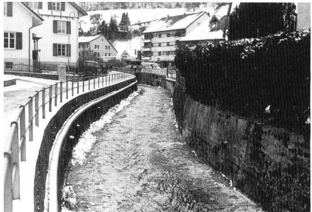
Bild 3. Vordere Frenke im Siedlungsgebiet: Der Fluss wurde kanalisiert, die Gewässersohle gepflastert. Die Vordere Frenke hat ihre Funktion als Lebensraum eingebüsst.
