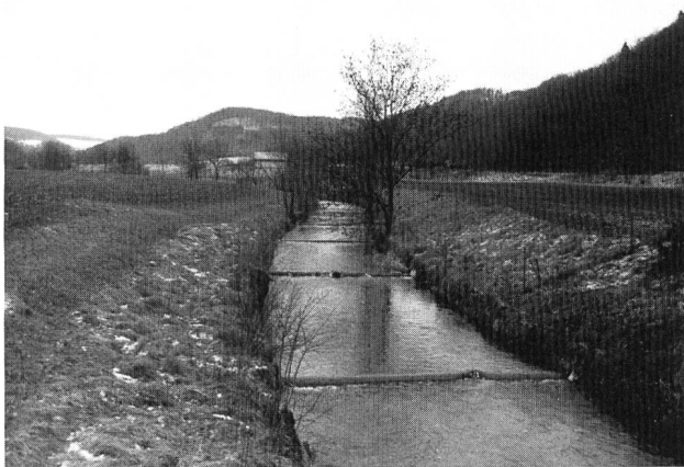
Bild 2. Monotoner Gewässerabschnitt im Landwirtschaftsgebiet: Die Gewässersohle ist mit Schwellen stabilisiert, der Böschungsfuss mit Betonplatten verbaut, das Umland intensiv genutzt.
