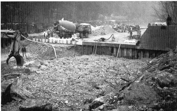
Bild 3. Bau des Tubeflüelwehrs in Burgdorf in den Jahren 1985/86.
