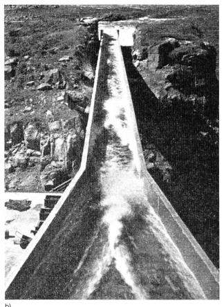
Bild 3. Stosswellen in Schussrinnen-Kontraktionen, bemessen nach dem Interferenzprinzip. Deutlich sichtbar starke Wellenentwicklung im Unterwasser. Blick in Fliessrichtung a) hydraulisches Halbmodell, b) Prototyp Peribonka Nr. 1 der Kanadischen Aluminium Gesellschaft (*Heartz* et al., 1954).
