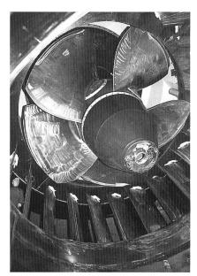
Bild 1. Turbinenlaufrad der Flusskraftwerke Wildegg-Brugg.
