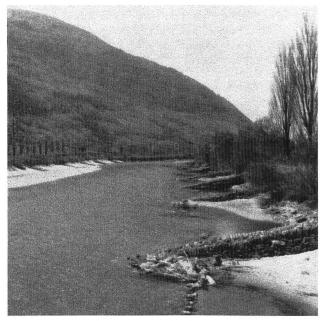
Photo 1. Système épis de la 1<sup>re</sup> correction du Rhône.
