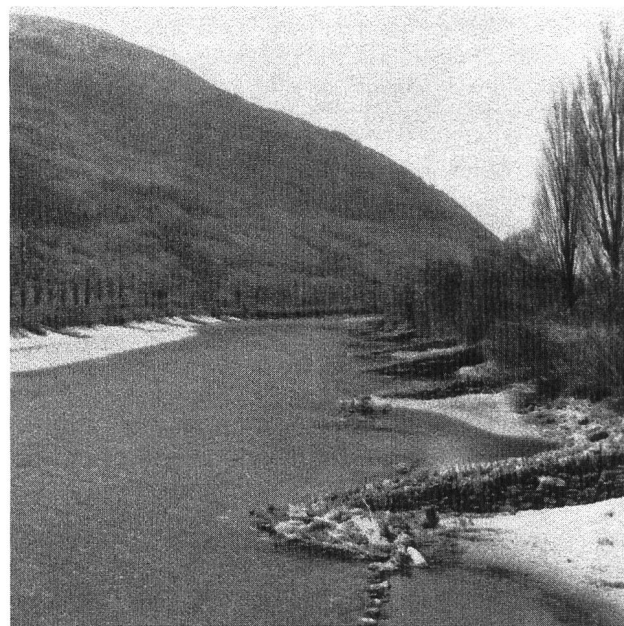
Photo 1. Système épis de la 1 re correction du Rhône.
