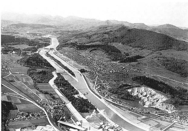
Figure 3. Usine de Ruppertswil sur l'Aar. Etanchement de la digue par injection de gels d'argile ciment. Argile bentonitique à opaline. Swissboring 1946 (Photo Swissair).
