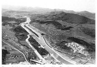
Figure 3. Usine de Rupperswil sur l'Aar. Etanchement de la digue par injection de gels d'argile ciment. Argile bentonitique à opaline. Swissboring 1946 (Photo Swissair).
