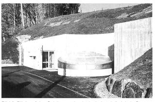
Bild 6. Blick auf den Schützenschachtdeckel und die lokale Steuerstelle.
