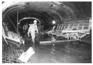
Bild 2. Betonieren der UW-seitigen Stollensohle mit Konterschalung.
