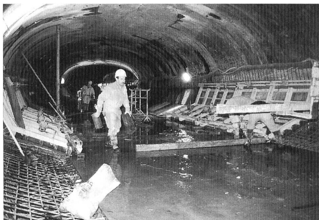
Bild 2. Betonieren der UW-seitigen Stollensohle mit Konterschaltung.
