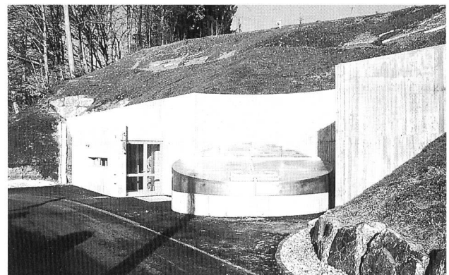
Bild 6. Blick auf den Schützenschachtdeckel und die lokale Steuerstelle.
