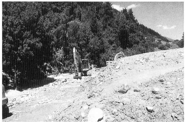
Bild 2. Steinhaus-Niederwald VS, 5. Juli 1998. Stau der Rotte/Rhone infolge von Murgängen des Rufibaches. Das Bild zeigt die sofort eingeleiteten Baggerarbeiten, um eine Verklausung zu verhindern (Foto: C. Hegg, WSL).
