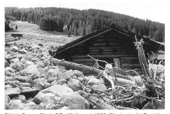
Bild 4. Davos-Glaris GR, 15. August 1998. Ein durch die Geschiebeausbrüche des Chummerbaches beschädigtes Gebäude im Kegelbereich. Insgesamt lagerte der Bach rund 50000 m³ Material ab (Foto: C. Hegg, WSL).
