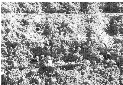
Bild 2, links. Nichtgeschalter Walzbeton auf der Luftseite des Quail Creek South Dam in Utah, mit einem mittleren Bindemittelgehalt von 133 \text{ kg/m}^3 und einer Schichtdicke von 30 cm.
