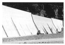
Bild 2, links. Nichtgeschalter Walzbeton auf der Luftseite des *Quail Creek South Dam* in Utah, mit einem mittleren Bindemittelgehalt von 133 kg/m³ und einer Schichtdicke von 30 cm.
