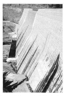
Arbeitstagen einbaute. Die maximale Tagesleistung von 18 000 m³ stellte bis mindestens 1996 einen Weltrekord dar (Hansen, 1996a). Im Plunge Pool-Tosbecken wurde ausserdem erodierter Fels mit Walzbeton ersetzt. Selbst ein Hochwasserabfluss von 11 300 m³/s über sechs Stunden hinterliess keine Erosionsschäden (Chao & Johnson, 1979). Insgesamt wurden zwischen 1974 und 1986 bei acht verschiedenen Sanierungsarbeiten am Tarbela Dam 2,7 Mio m³ Walzbeton verwendet
