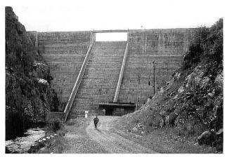
Bild 5. Ansicht des *Stagecoach Dam* in Colorado mit konventionellem Beton auf der Luftseite und Krafthaus am Mauerfuss.
