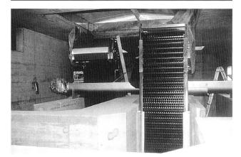
Figure 5. Une seconde étape de dégrillage-tamisage assure l'élimination de toutes les particules d'une dimension supérieure à 3 mm.
